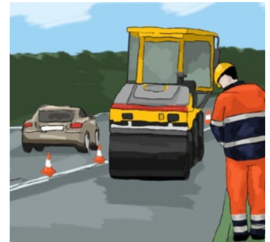
Рис. 1. Огораживание работ с движением при помощи дорожных конусов
